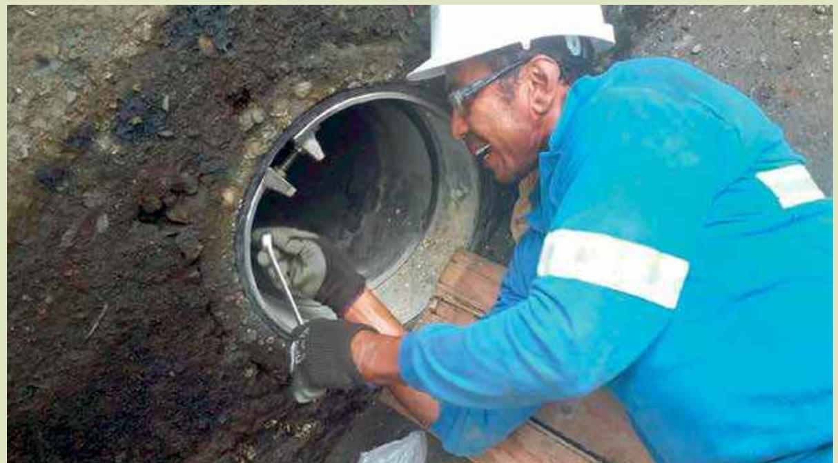
Las válvulas, ya instaladas, evitan el paso del flujo de aguas lluvias en dirección contraria y evitan los perjuicios de una marea alta.
