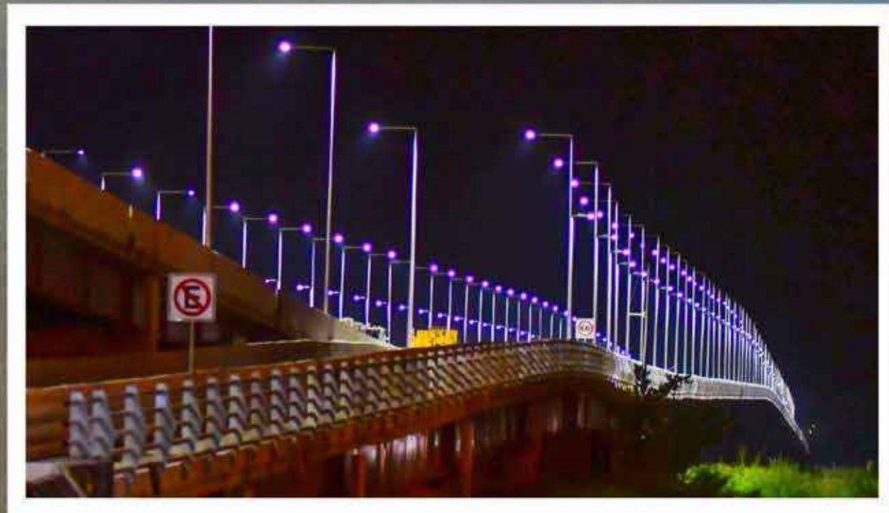
La obra recibe los últimos toques y en unos días más el puente será estrenado para bienestar de quienes día a día se movilizan entre estos dos cantones del Guayas
