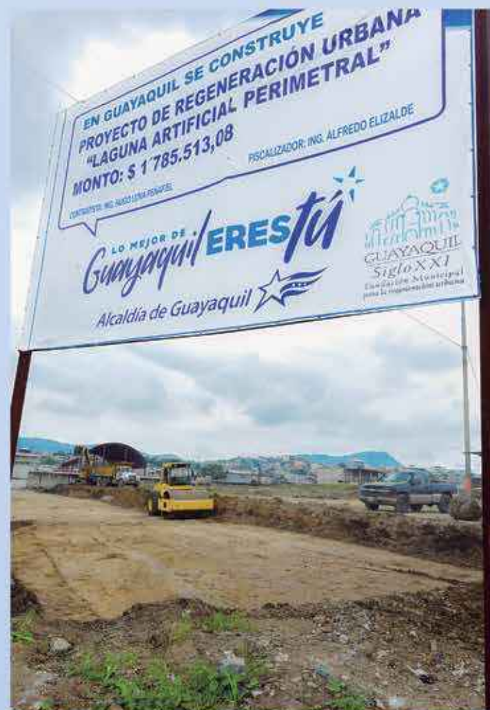
La vía Perimetral contará con una hermosa laguna artificial para disfrute de quienes moran en ese populoso sector de Guayaquil y de toda la colectividad. Por el momento, avanzan los trabajos de construcción.
