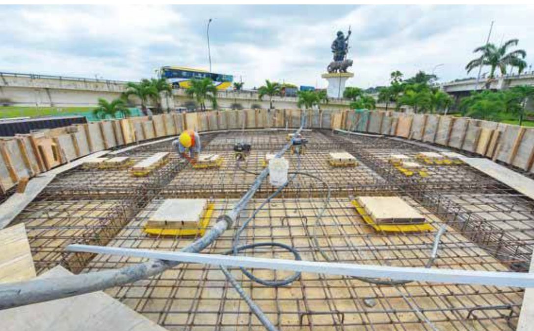
En la fuente constan dos estanques, el mayor de 30 metros de diámetro y uno menor y central de 10 metros.
