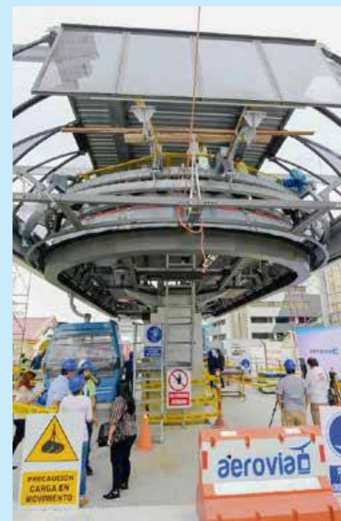
El sistema aerotransportado Aerovía avanza en su construcción y en el 2020 será inaugurado.
